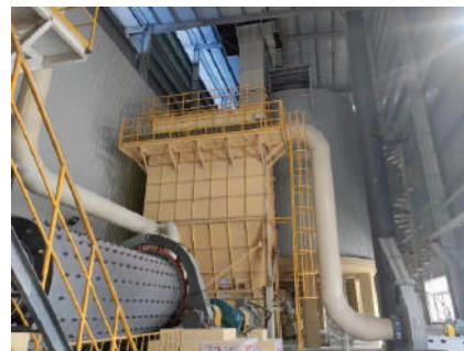
“近零废弃物排放”工厂
