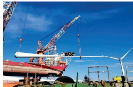
吊装123米风电叶片
