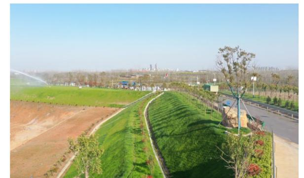
在运输道路和挖运过程中进行洒水降尘工作，有效减少运输和挖装过程中扬尘污染
