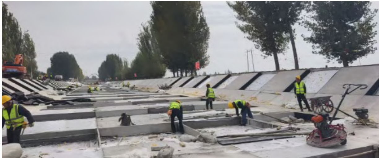
赛马科进实地踏勘青铜峡灌区改造工程现场
