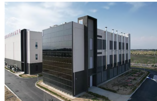
互联网产业园数据中心屋顶光伏
