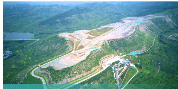
平阴山水水泥矿山
