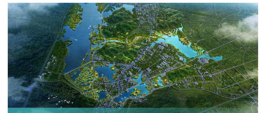
枞阳县水环境综合治理项目
