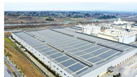
巨石成都智能制造基地投运了成都最大11.6兆瓦分布式光伏电站。
