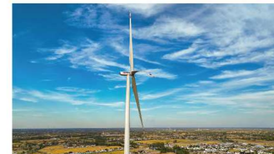
吊装完成的风力发电机组。
