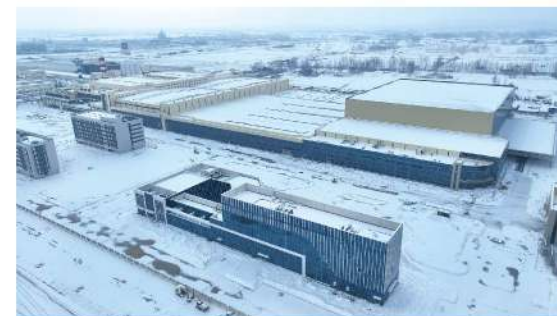
中国巨石淮安涟水零碳智能制造基地一期项目建设有序推进。
