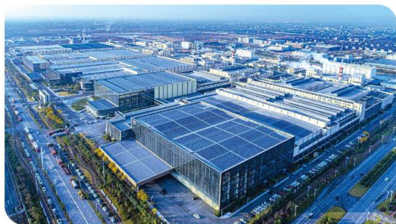
在桐乡总部，我们60万平方米的屋顶，实现太阳能光伏板全覆盖，每年发电近7000万千瓦时，并全部用于生产。
