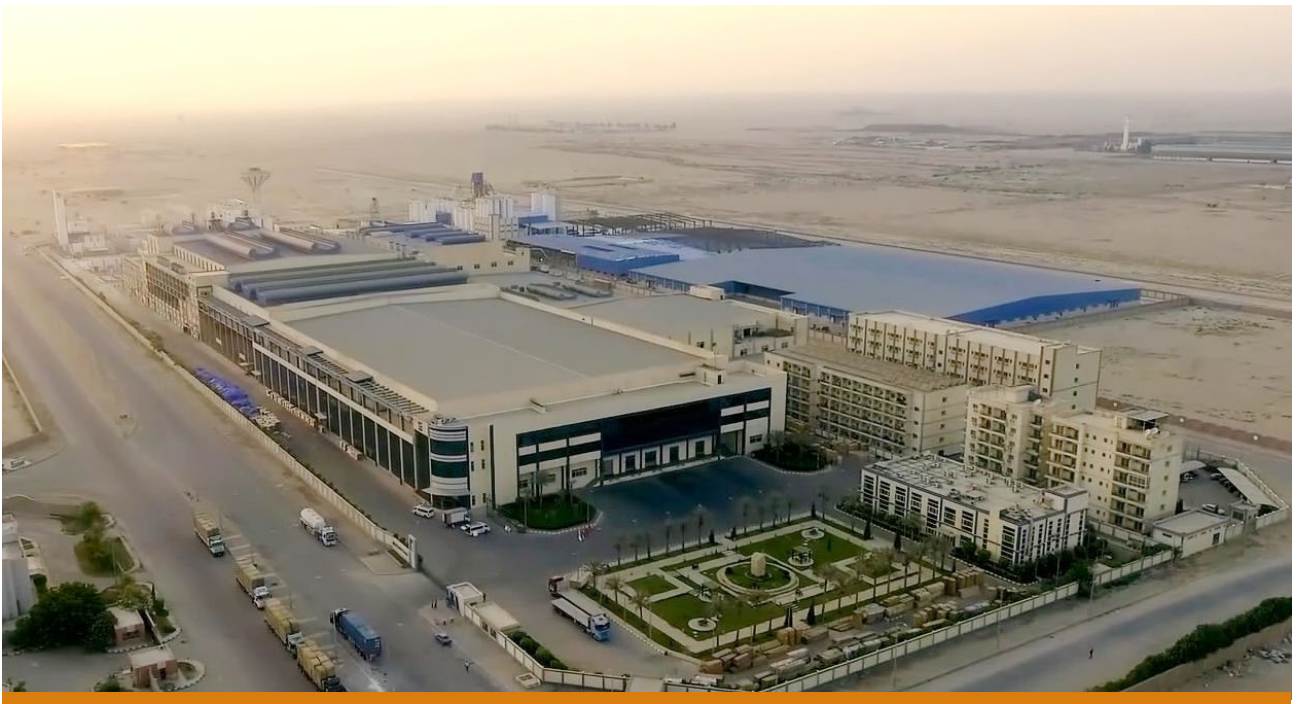
巨石埃及年產20萬噸玻璃纖維生產基地
