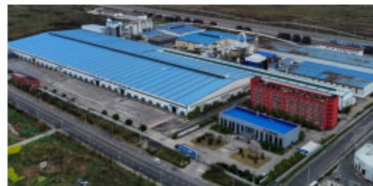
龙牌新材料（重庆）有限公司全貌
