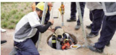
● 开展有限空间作业全程仿真实训演练
