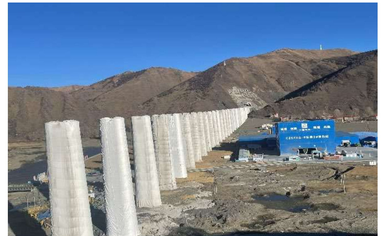
川藏铁路工程现场
