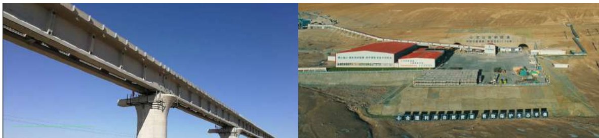
新疆格库铁路项目、乌尉公路项目施工现场
