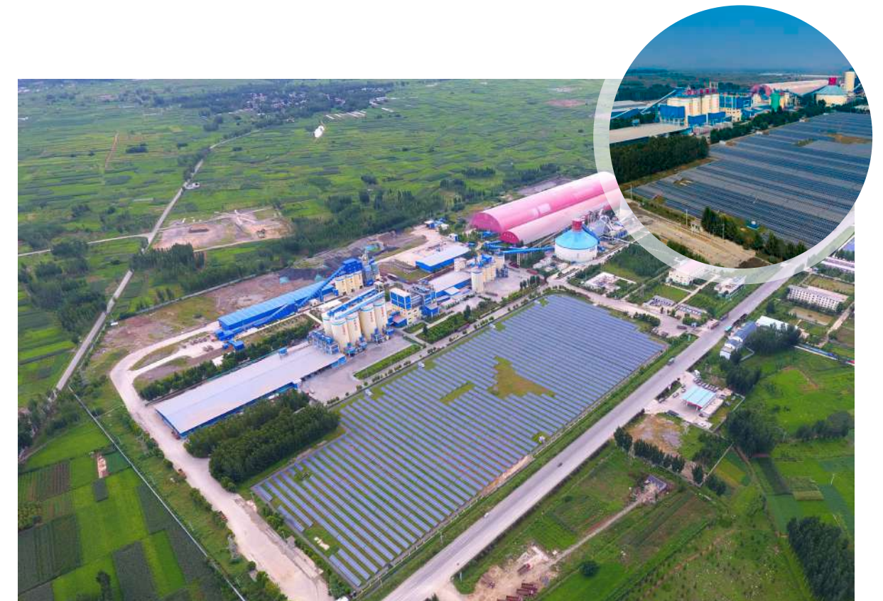
临沂中联光伏发电项目
