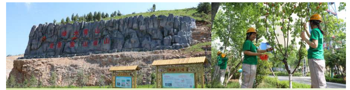
平邑中联矿山生态修复工程
