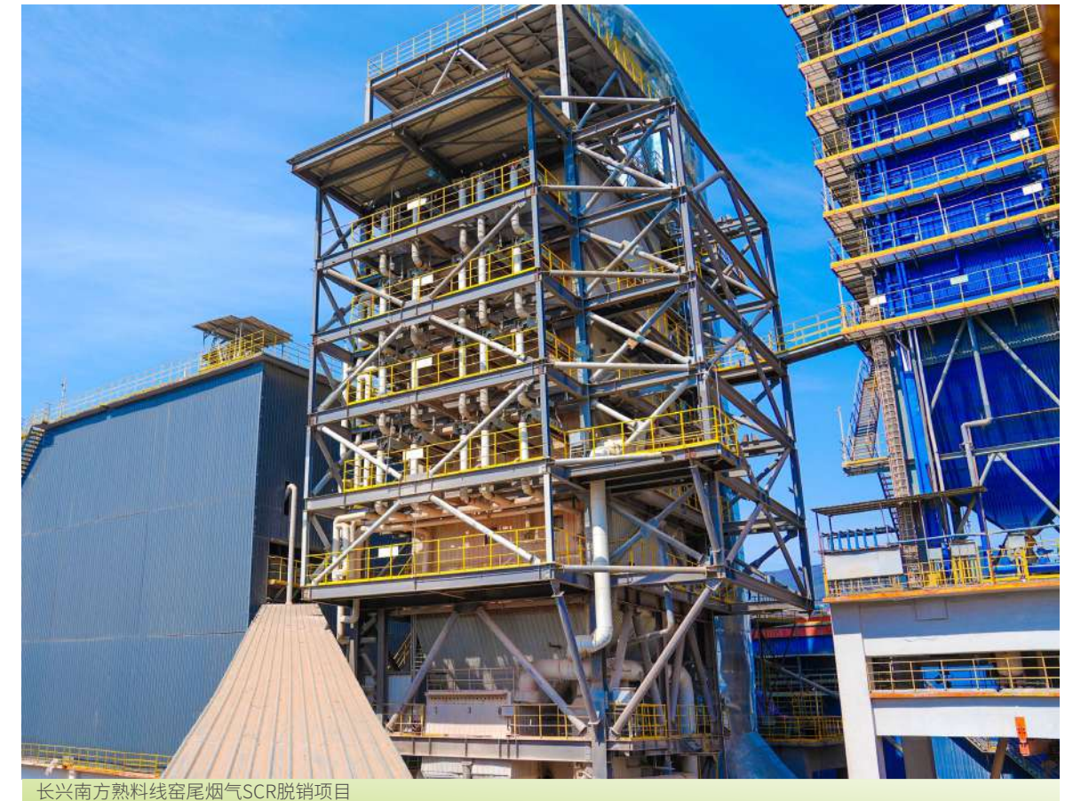
长兴南方熟料线窑尾烟气SCR脱硝项目
