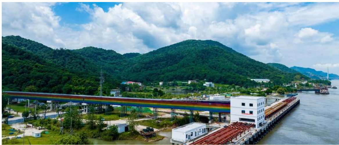
瑞昌骨料廊道光伏发电项目
