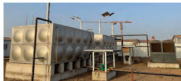
中材建设塞内加尔SC3项目营地太阳能热水系统
